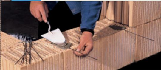
So entsteht eine zweischalige Wand. Im ersten Schritt gehen Mörtel, Hintermauersteine und Maueranker eine feste Verbindung ein.
