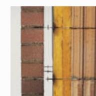
Zweischalige Wand mit Luft- und Dämmschicht
