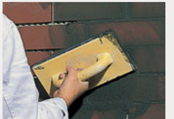
Bild 5: Insbesondere bei Klinkerriemchen mit sehr niedriger Wasseraufnahmefähigkeit besteht die Möglichkeit, die Fugen mit Schlämmörtel zu schließen.
