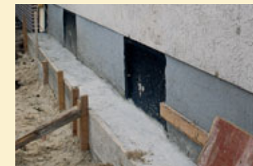
Bild 1: Für eine nachträgliche Verblendung kann die Anlegung eines Streifenfundamentes erforderlich sein ...
