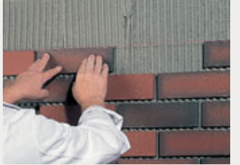
Bild 1: Die Riemchen werden im Floating-Buttering Verfahren verklebt.
