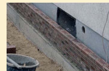
Bild 3: Für die Aufmauerung der Verblendschale sind die Bestimmungen der DIN 1053-1 maßgebend.
