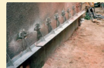
Bild 2: ... oder das Anbringen einer Abfangkonsole zum Auflagern.
