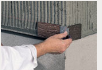
Bild 3: Auch werden an allen Gebäudeecken Winkelriemchen eingesetzt.
