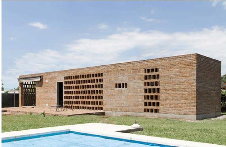
**Bildunterschrift:** Trotz des schlichten Auftretens sorgen die unterschiedlichen Mauerverbünde für eine unaufdringliche Abwechslung in der Wandabwicklung. An manchen Stellen lösen sich die doppelschaligen Wände in einschalige durchbrochene Abschnitte auf. (Casa AR | Valeria Del Vecchio. Arquitecta | Einreichung im Rahmen des Fritz-Höger-Preises 2020 für Backstein-Architektur)
