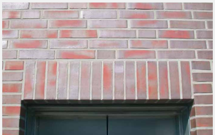
Sturz im Ziegelverblendmauerwerk aus „gemauerte Rollschicht“ (Grenadierschicht)
